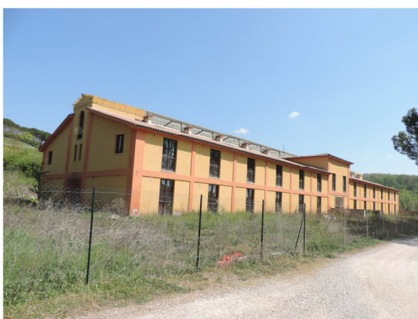
Vista dell'edificio – lato sud-ovest ed nord-ovest
