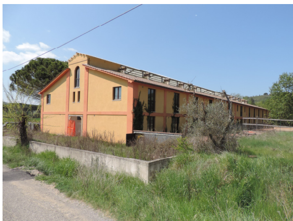
Vista dell'edificio – lato est e nord
