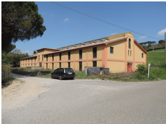
Vista dell'edificio – lato sud-est e sud-ovest
