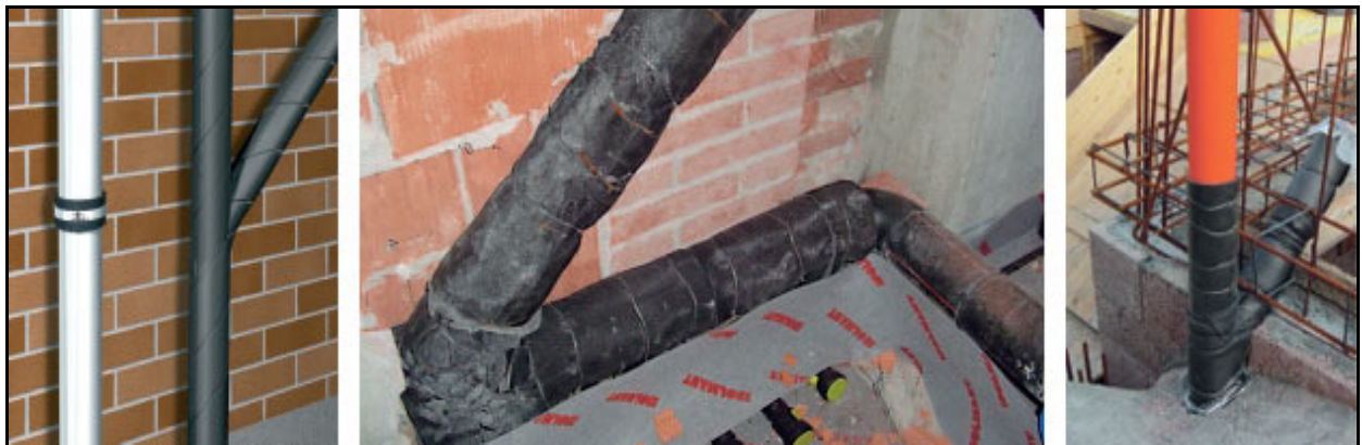
Fig. 10 - Esempi di messa in opera
